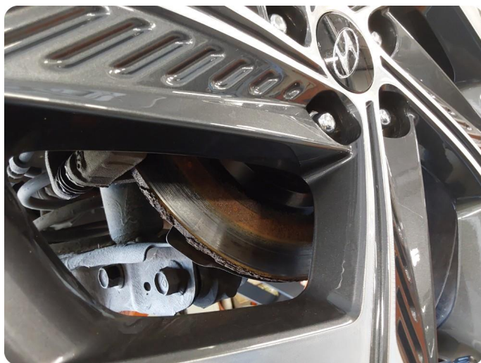
2.1 Rust Rust på bremseskiver høyre bak, bør byttes
