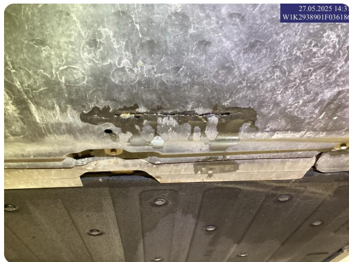
1.3 Beskyttelsesplate skadet/mangler Skade plate under fremre motor
