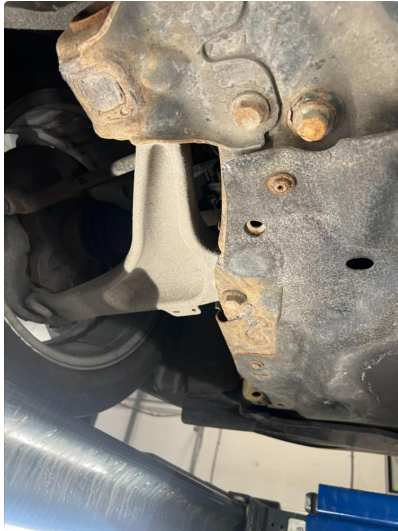
1.2 Stedehvis noe overflaterust under bilen.
