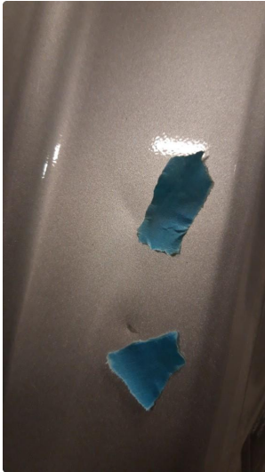
1.1 Småbulker i døråpning/innsteg
