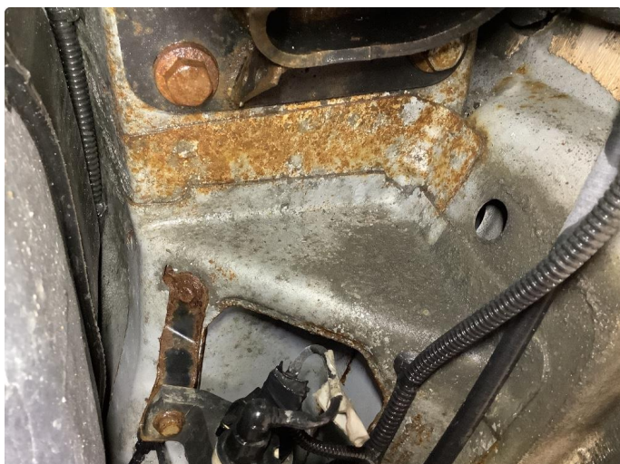
1.1 Noe begynnende korrosjon under bil.
