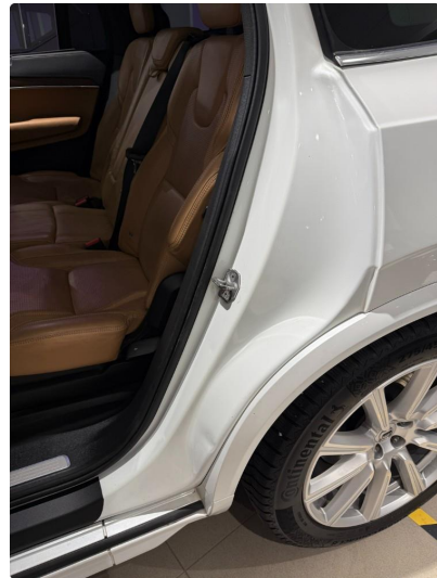
1.3 Flere små bulker døråpninger begge sider bak.
