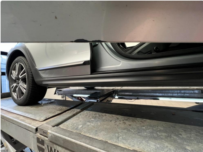
1.1 Korrosjon framdør høyre.
