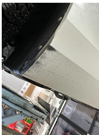
1.3 Slitt lakk begge sider kanal.
