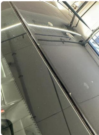
1.3 3 steinsprang framkant tak.
