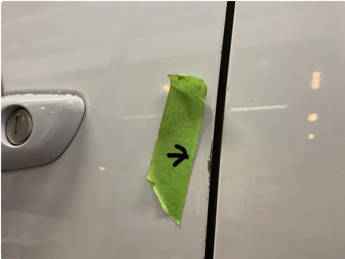
1.1 V for dør liten lakkskade
