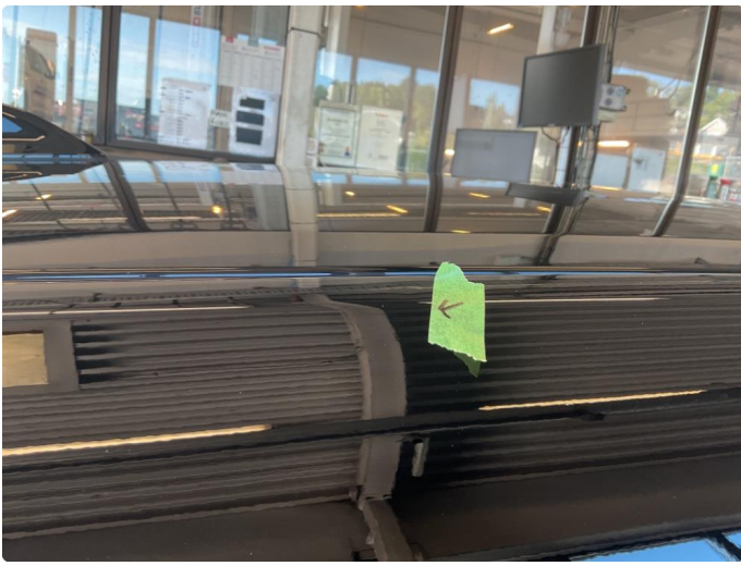
1.2 Bulk på c stolpe oppe ved tak begge sider
