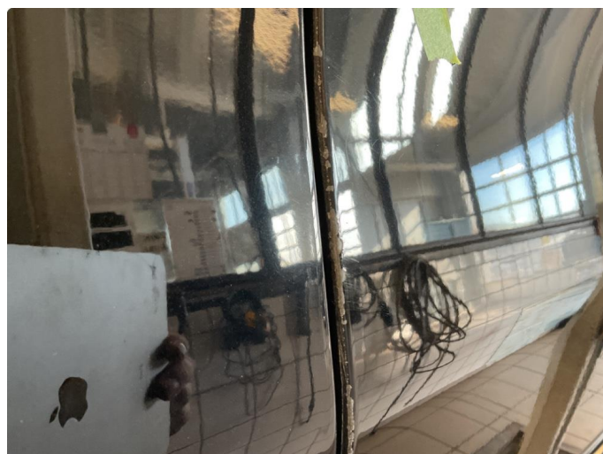
1.2 Bulker i v skyvedør med lakk sår
