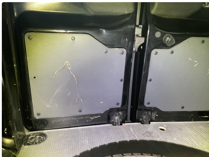
2.1 Skade på deksler i varerom
