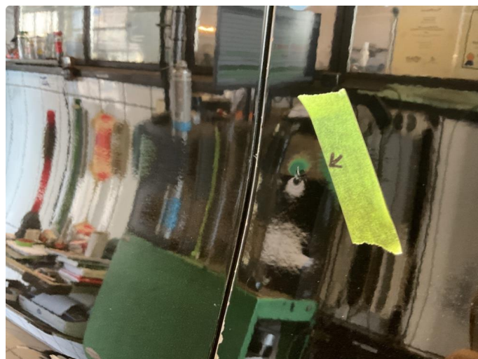
1.2 Bulker i v skyvedør med lakk sår
