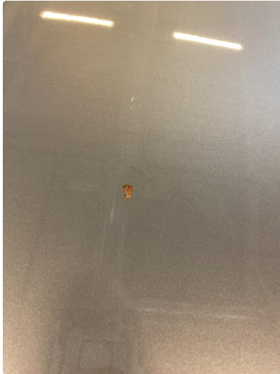
1.1 Noe steinsprut med rust
