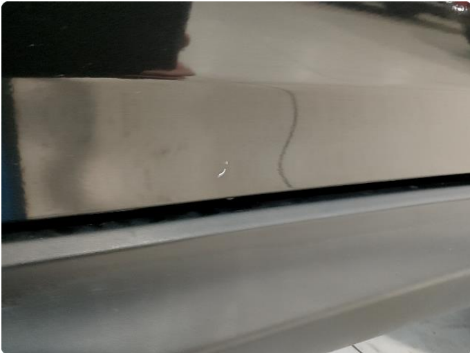
1.1 Små hakk, ikke igjennom grunning - blir penslet før levering
