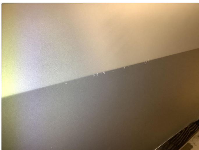
1.2 Ripe ned til grunning
