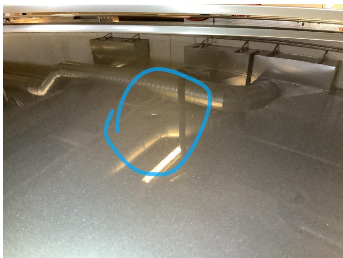
1.5 Bulk med lakkskade
