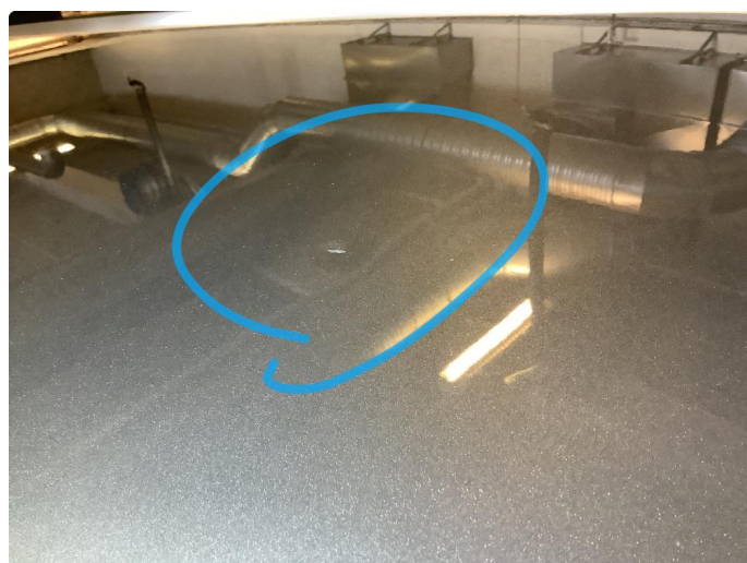
1.5 Bult med lakkskade
