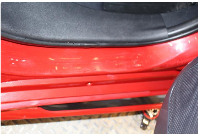
1.2 Noe riper i innsteg
