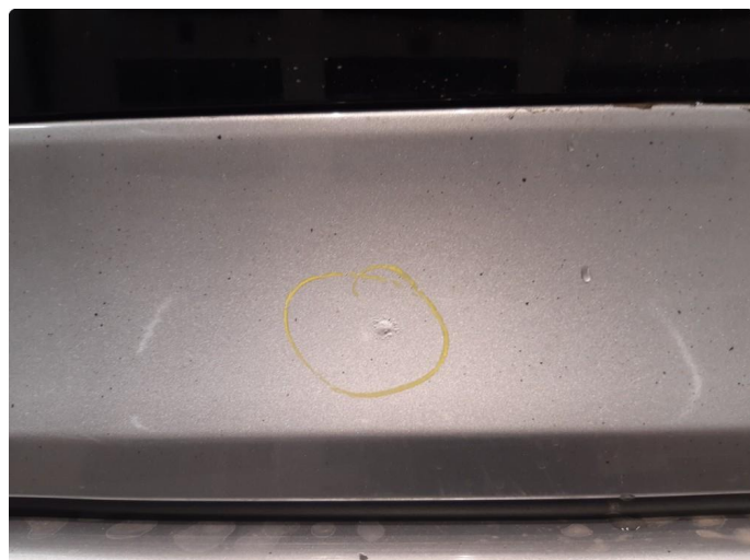
1.2 Steinsprut med rust
