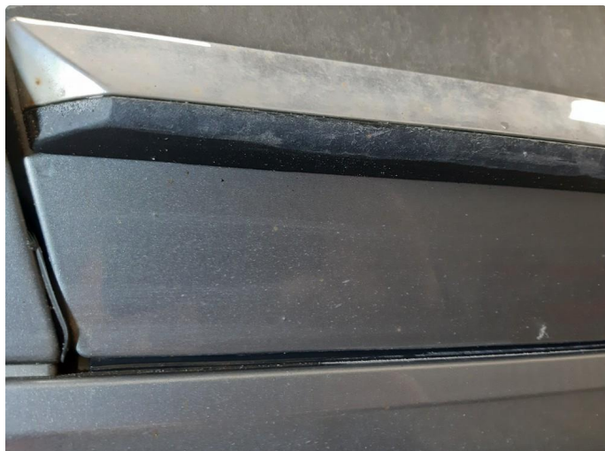
2.1 Steinsprut med rust
