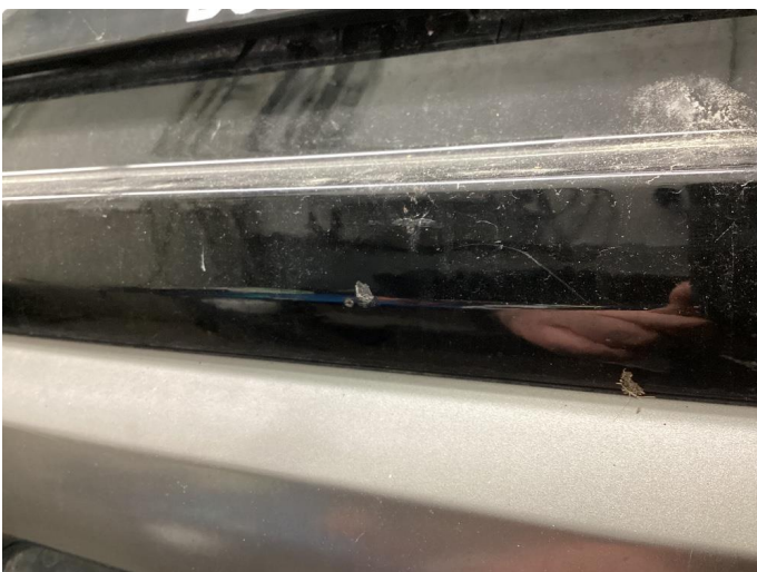
1.5 Ripe(r) ned til grunning
