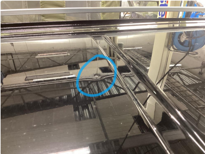
1.2 Liten bulk med lakkskade som er flekket
