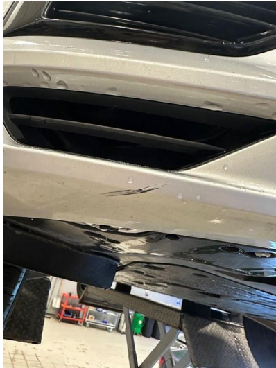
1.1 Litt oppripet på underside av fanger foran
