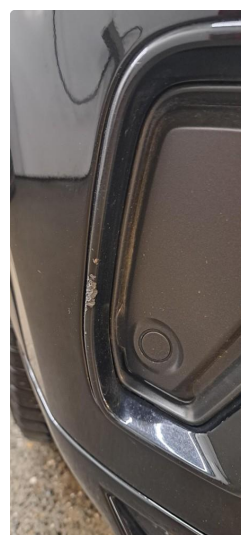
1.4 Svak bulk og ett lite hakk i fanger høyre foran
