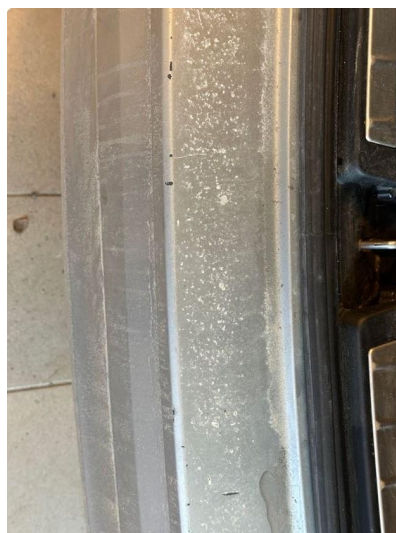
1.2 Noen riper i lastesone fanger bak
