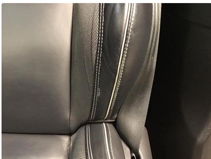
2.1 Liten slitasje på sidestøtter
