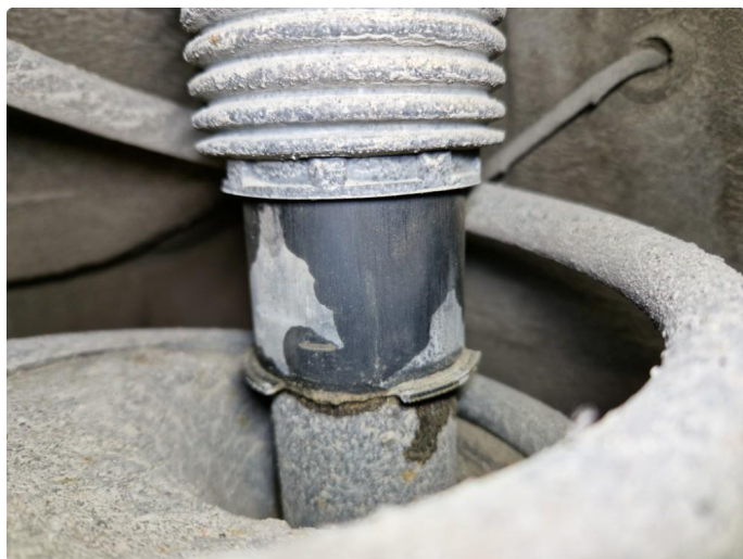
4.2 Svetting / liten lekkasje støtdemper h-fram.
