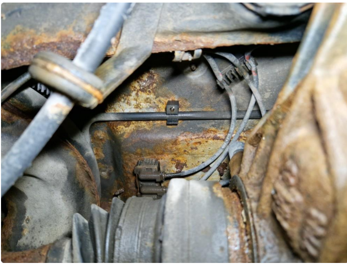
2.1 Rust underside ved bakstilling.
