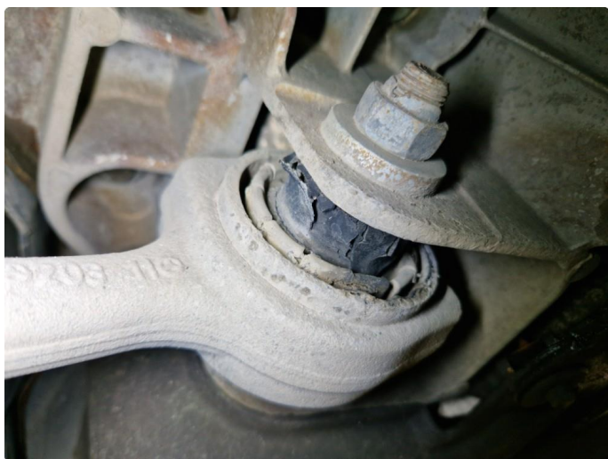
5.4 Utslitt indre / bakre bæreamsforing h+v fram.
