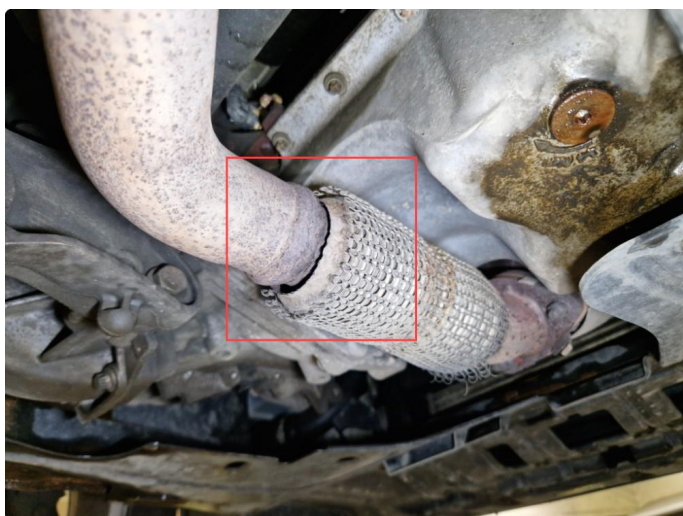
4.1 Defekt flexikobling , noe eksoslekkasje.
