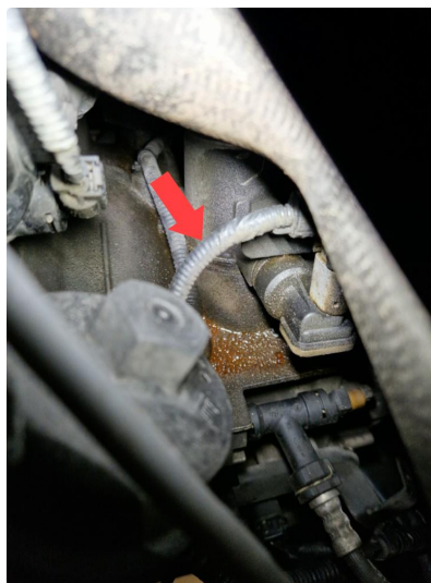
6.1 Lekkasje girkasse / girvelgerhus ( Byttes pakning ).
