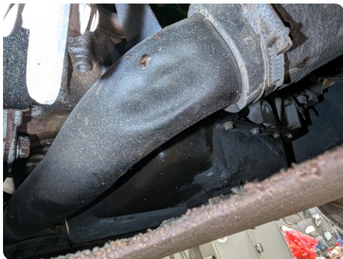
4.2 Øvrige feil Ser ut til å være en liten oljesvetting under motor
