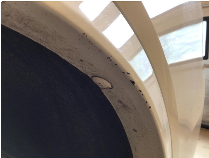
1.1 Steinsprut i plast på hjulbue
