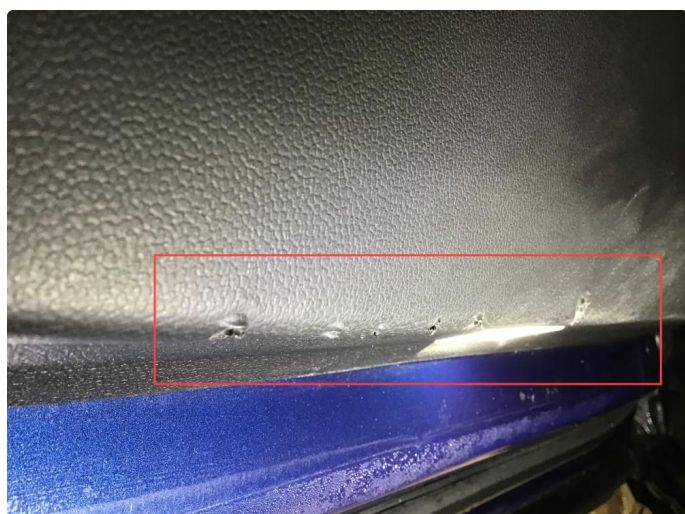
3.1 Noen merker i dørtrekket på førerdør.
