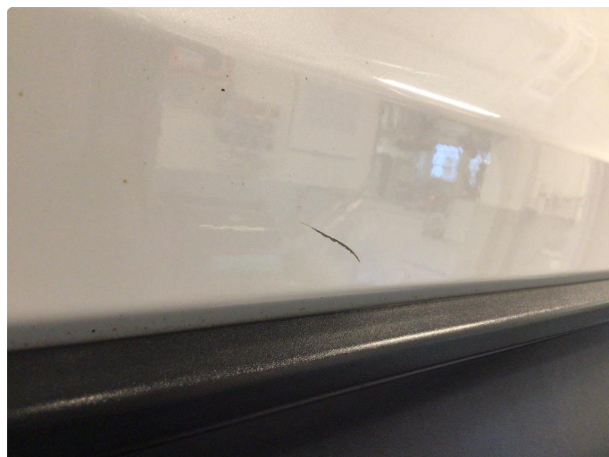
1.2 Ripe ned til grunning
