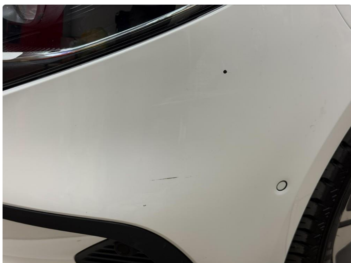
1.1 Ripe(r) ned til grunning
