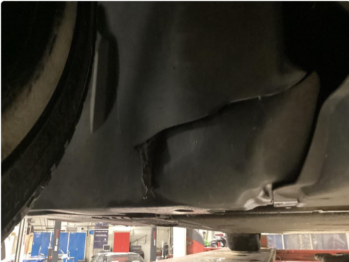
1.1 Plastinnerskjerm liten skade., høyre side bak.
