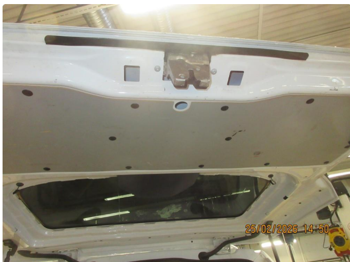
2.1 Diverse riper og slitasje i varerom
