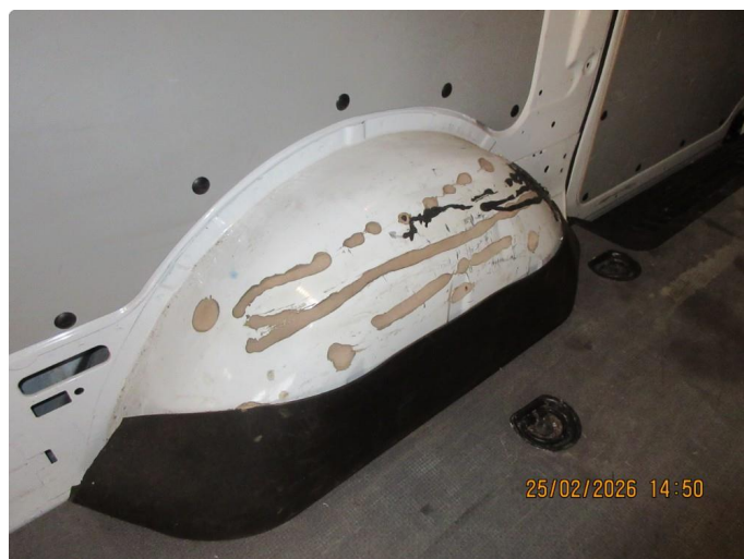
2.1 Diverse riper og slitasje i varerom
