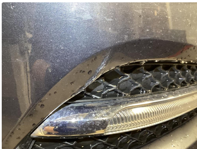
2.1 Er en del bruksslistanje i lakk mtp alder. Noen liott kraftigere riper i støtfanger bak
