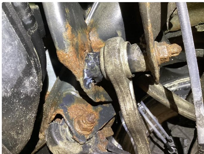
2.3 Noe overflaterust i travers bak. Ikke noen hull eller større skader,
