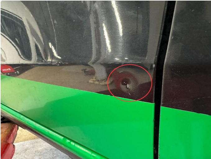
1.3 Noen bulker på førerdør.
